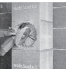
Ausschneiden (oder Ausbohren) der lichten Weite für Rauchrohr- bzw. Putztüranschlusszarge.
