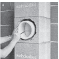
Original Schiedel-Rauchrohrstützen bzw. Putztürzarge zum Anzeichnen am Schamotterohr verwenden.
