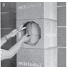
Schiedel Dämmatte mit Messer durchschneiden und entfernen.
