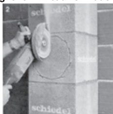
Aufschneiden des Mantelsteines mittels Trennscheibe (im Rohbau). Ausbohren mit Bohrmaschine (staubfreie Methode in bewohnten Räumen).
