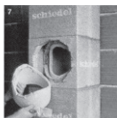
Alle Schamotteteile anfeuchten, anschließend Fugenmasse auf Rauchrohr- bzw. Putztürzarge auftragen u. auf Schamotterohr festdrücken.
