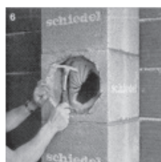
Schamotteteile vorsichtig entfernen.
