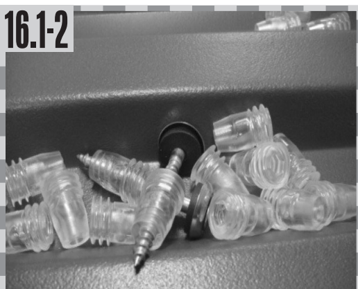
Abstandshalter und Schrauben auf der Bedachungsplatte ablegen
