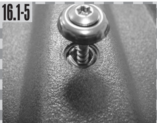
Spenglerschraube setzen...
